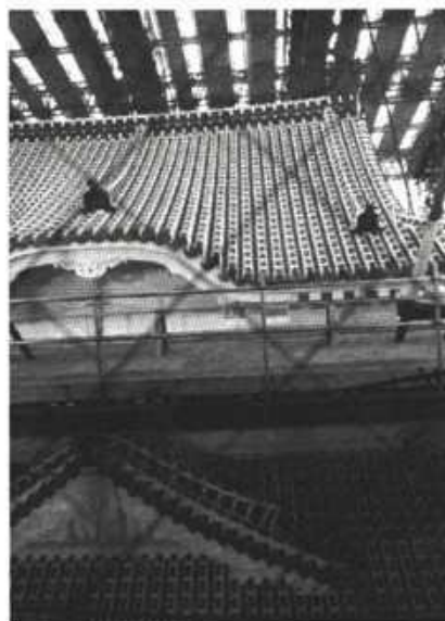
修復中の姫路城(2013年12月撮影)
